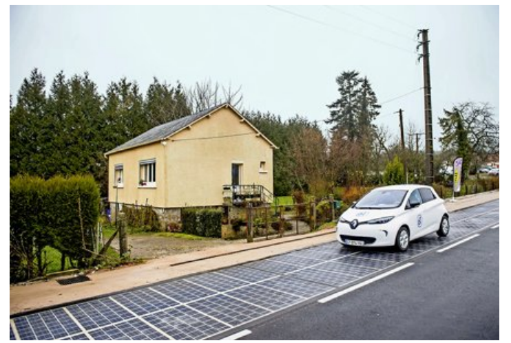
Le kilomètre de dalles photovoltaïques à Tourouvre. EPA
